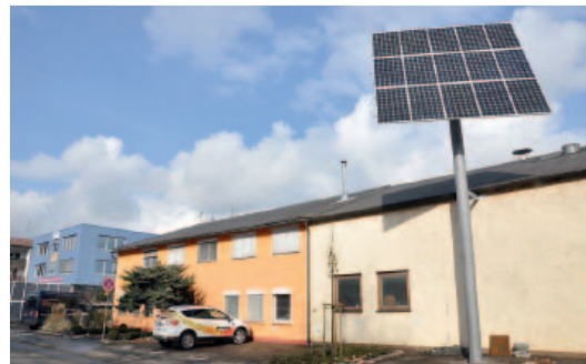
Regenerative Energien im Gewerbegebiet Neckarwiesen: Projekt SONNENWERKE (Esslingen a.N.)
