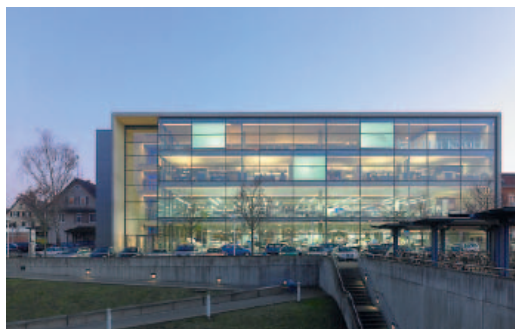
Stapelung von Nutzungen: Multifunktionsgebäude der Walter Knoll AG (Herrenberg)
