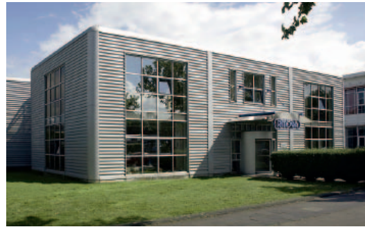
Mehrgeschossige Produktion auf zwei Ebenen: RIMOWA
