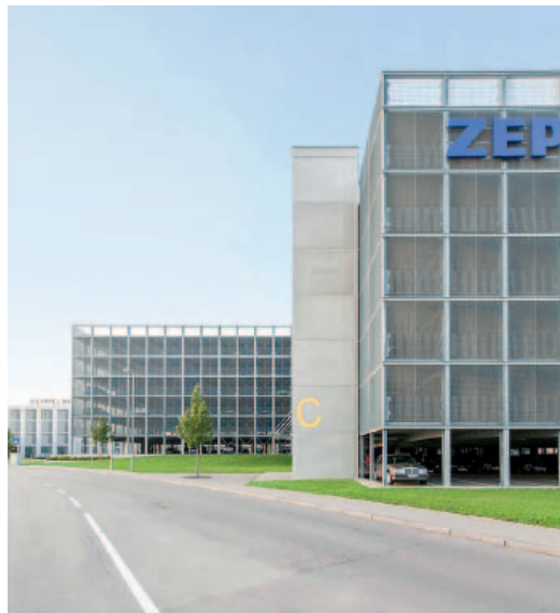
Zentrales Parkhaus (Friedrichshafen): Mehrgeschossiges Parken schafft Raum für Nachverdichtung des Gewerbegebietes
