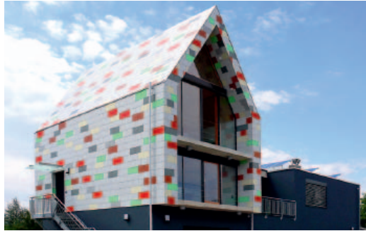
Aufstockung im Bestand – Büroräume im Spitzgiebel
